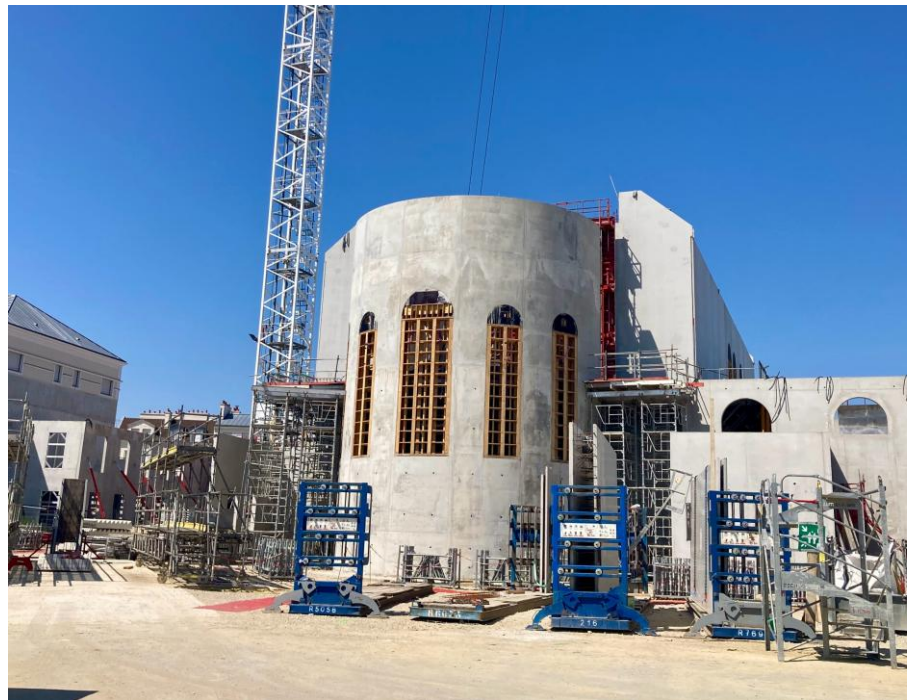
L'abside et ses cinq fenêtres... Sur la gauche, le centre paroissial
